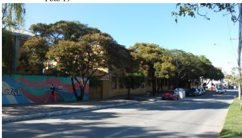
Foto 20 (Fachada/frente da escola)
