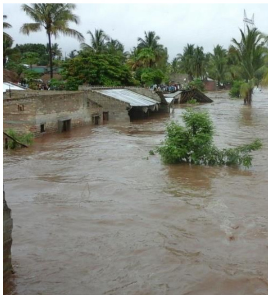
Figura 30 - Casas quase totalmente submersas em Chupanga (2008)
