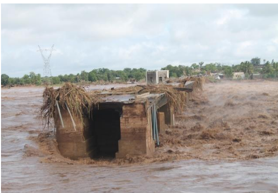
Figura 83 - Vista parcial da interrupção de via terrestre de Mopeia_Sede (2008)
