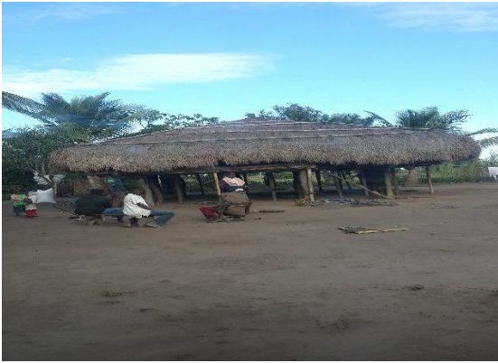
Figura 47 - Exemplo do tipo de casas construídas para enfrentar as cheias e inundações (2017)
