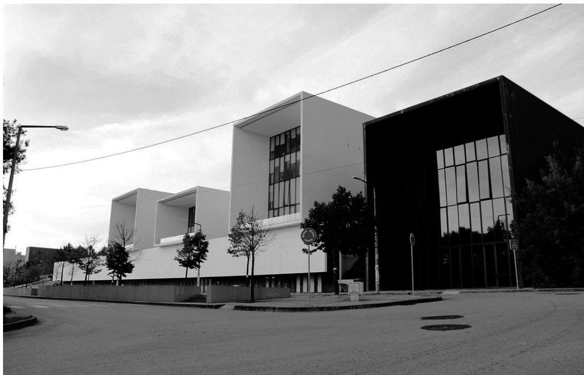
Fig. 12- Serviços Administrativos do Polo II, desenhado pelo Atelier Aires Mateus e Associados
