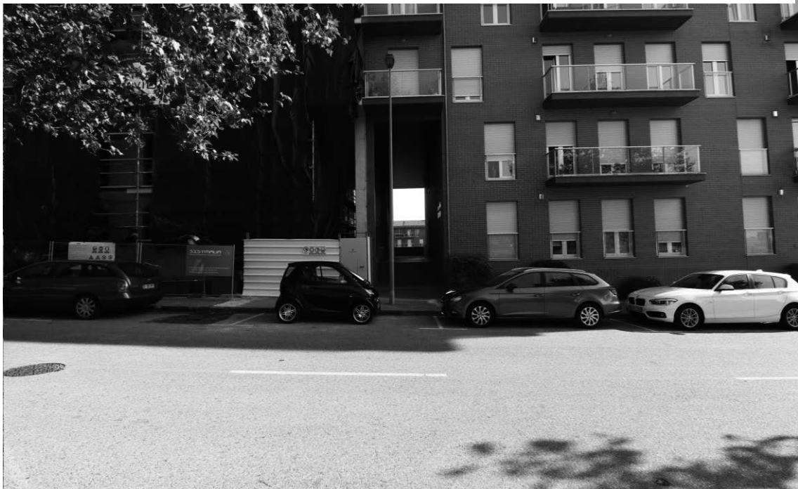
Fig. 9- Fachada de Edifício da Quinta da Portela
