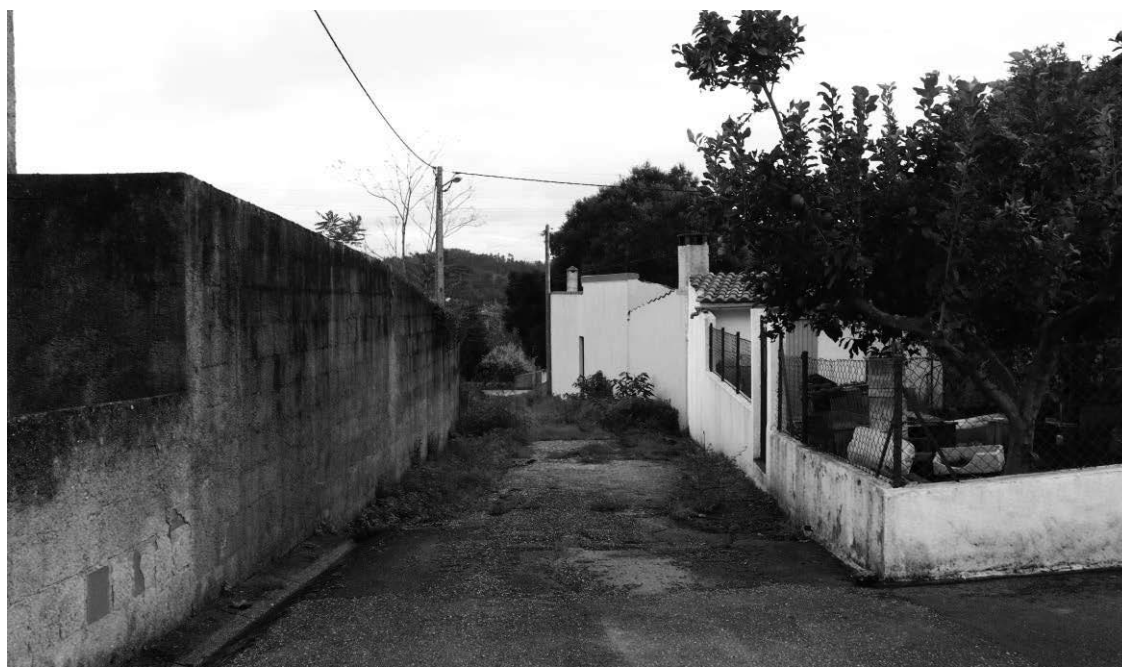
Fig. 15- Via obstruída de Vila Franca
