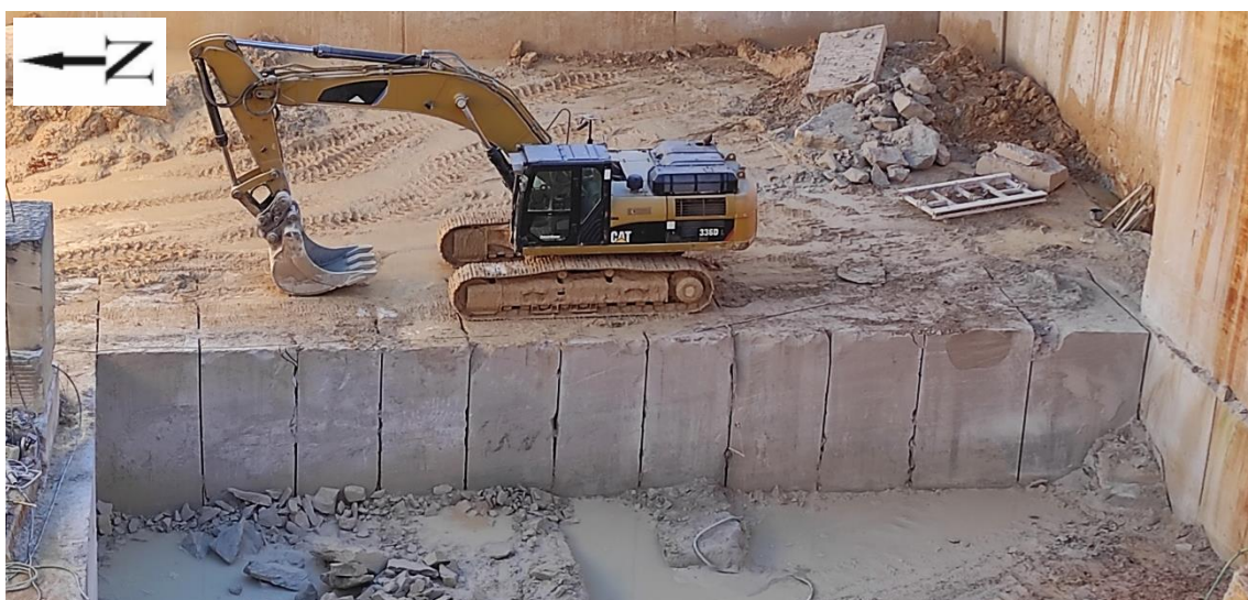
Figura 25 - Frente de desmonte relativa à TRE 3 sem qualquer processamento de imagem.
