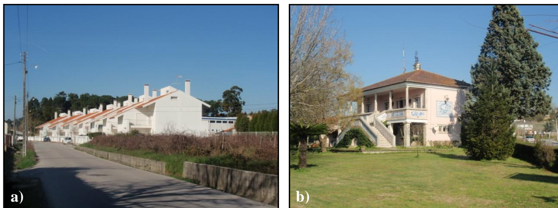
Foto 3.5 - Construção contínua e dispersa: urbanização em banda (a) moradia unifamiliar (b)
