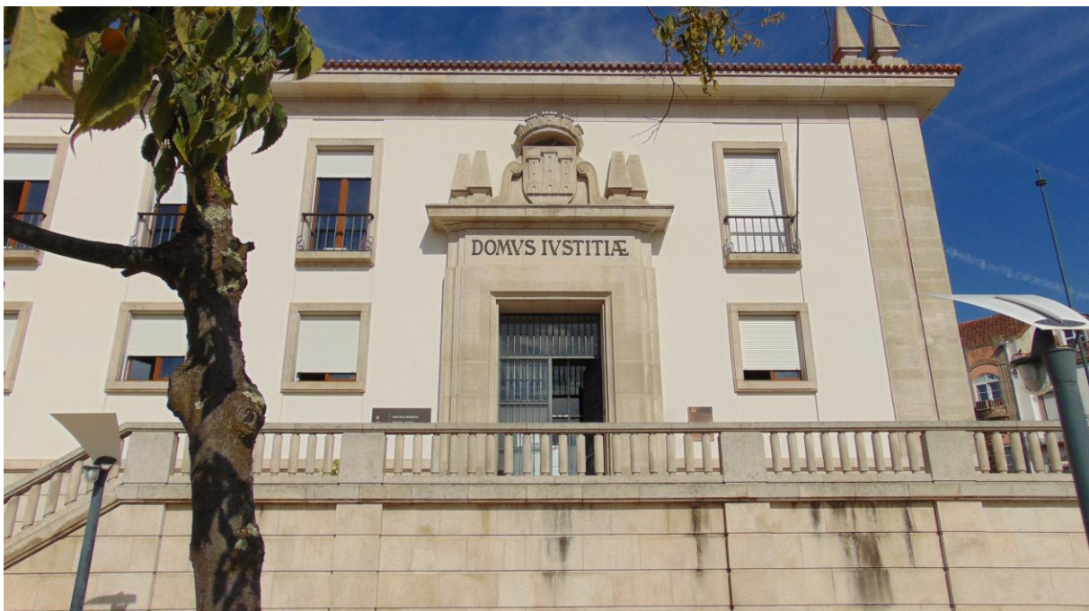
Figura 16 - Tribunal Judicial, Castelo Branco. Vista da fachada principal.
