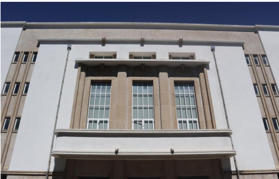
Figura 2211 - Cine - Teatro Avenida, Castelo Branco. Varanda da fachada virada para a Rua do Saibreiro.
