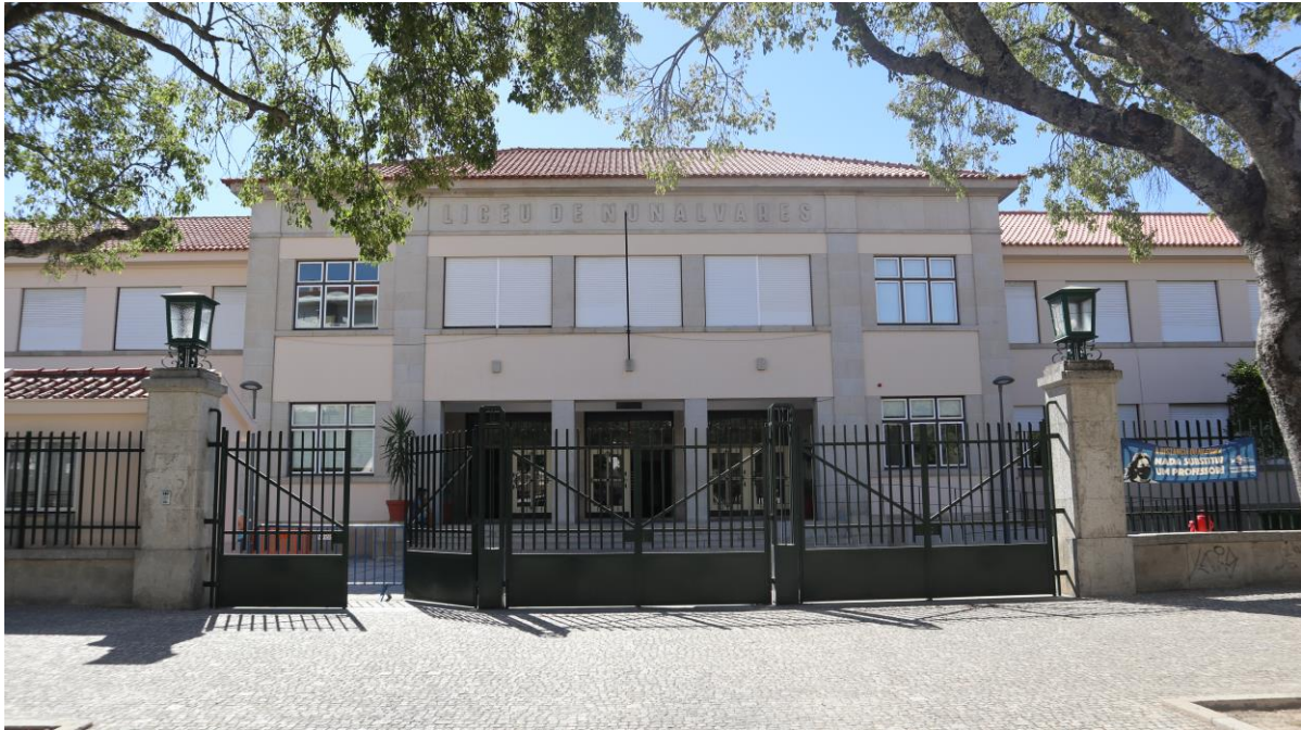
Figura 3 - Liceu Nun'Álvares, Castelo Branco. Vista sob a Fachada Principal.
