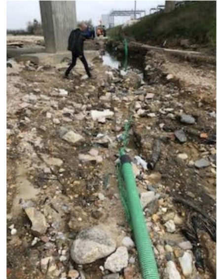
Fotografia 13 - ETAR de Moinhos e troço de caboduto de fibra ótica destruído na ocorrência do Elsa
