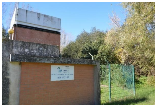
Fotografia 6 - Presença de vegetação descontrolada junto às instalações
