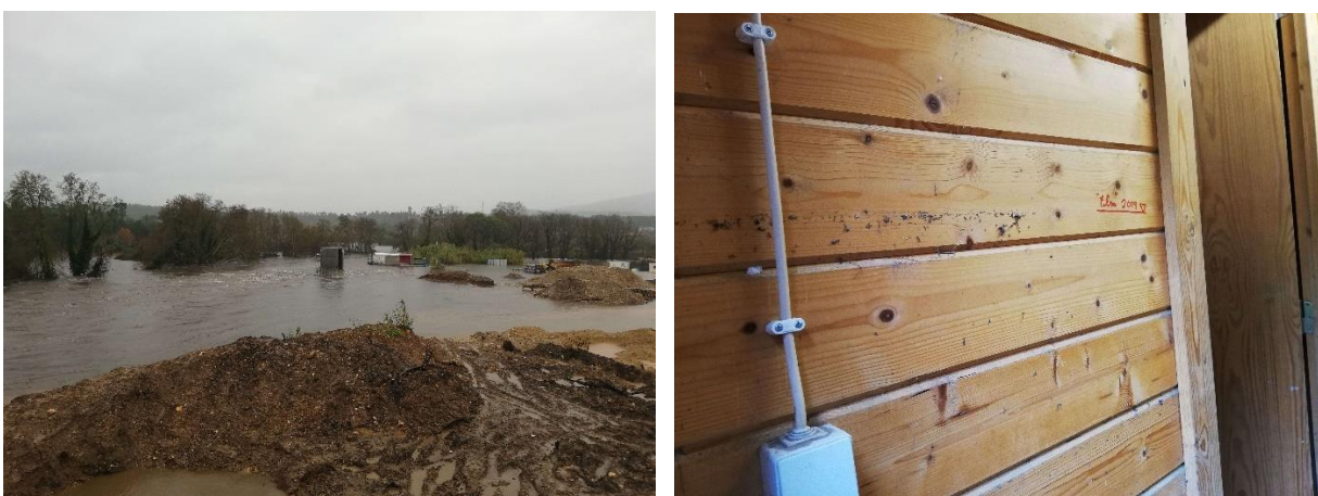
Fotografia 12 - ETA da Alagoa e ETAR do Caneiro na ocorrência do Elsa
