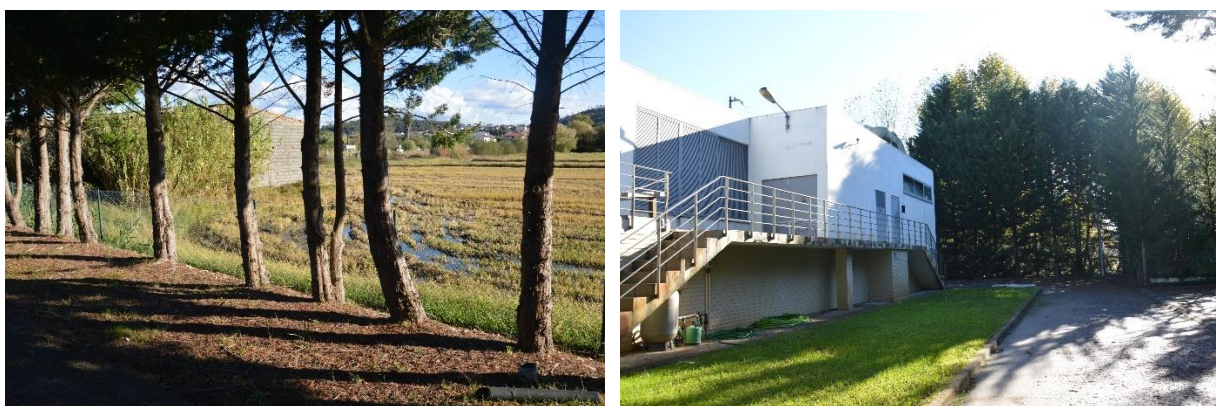
Fotografia 9 - Vulnerabilidade das instalações a cheias e inundações, com registo de ocorrências anteriores
