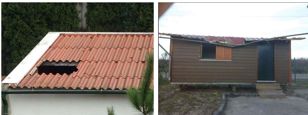
Fotografia 14 - Danos provocados pela passagem do Leslie na EE do Boco e na EE das Cochadas.
