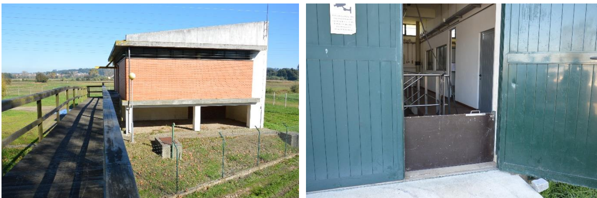
Fotografia 20 - Obras de prevenção operadas pela AdCL
