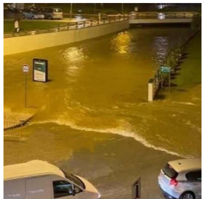
Fotografia 24: Inundação Túnel / passagem desnivelada. Fonte: https://www.sabado.pt/
