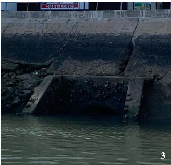
Fotografia 4: Ponto de descarga da bacia de drenagem “Tange”.
