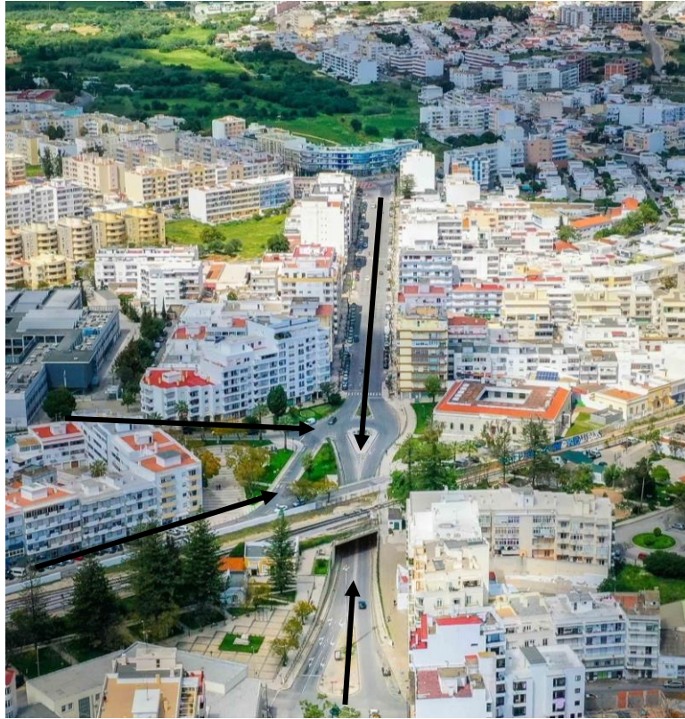
Fotografia 15: Vias que canalizam o escoamento para a passagem desnivelada. Fonte: Algarve Drone
