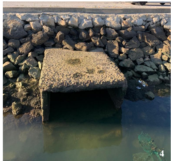
Fotografia 5: Ponto de descarga da bacia de drenagem “Brejo”.
