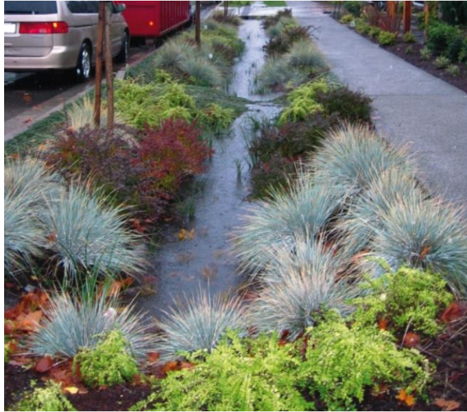
Fotografia 29: Swale com vegetação em zona urbana.
