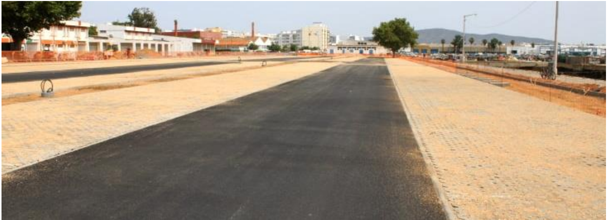
Fotografia 26: Pavimento permeável utilizado no novo parque de estacionamento da Avenida 16 de Junho em Olhão.
