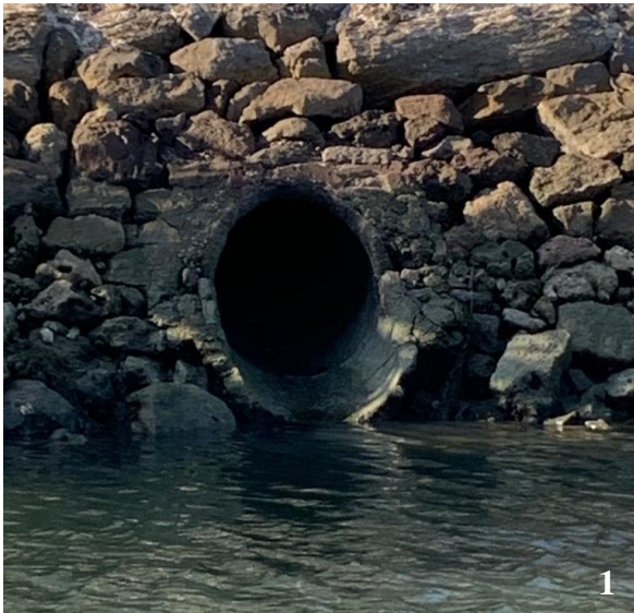
Fotografia 2: Ponto de descarga da bacia de drenagem “Jardins”.
