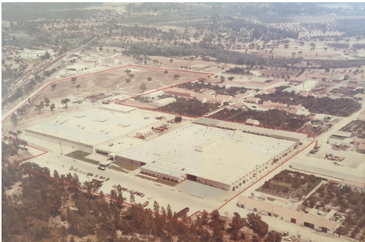
Figura 7 – Instalações da INLAN/DELPHI em Ponte de Sor (1980-2009)
