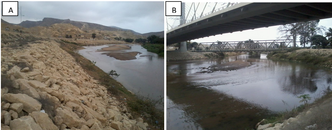
Figura 4.6- Área intervencionada Bairro do Chiúle (A) e Ponte sobre o rio Catumbela (B).
