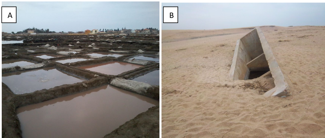
Figura 4.2- Bairro das salinas vítimas de inundação do Catumbela (A) Comportas antimarés no bairro da praia bebé (B).
