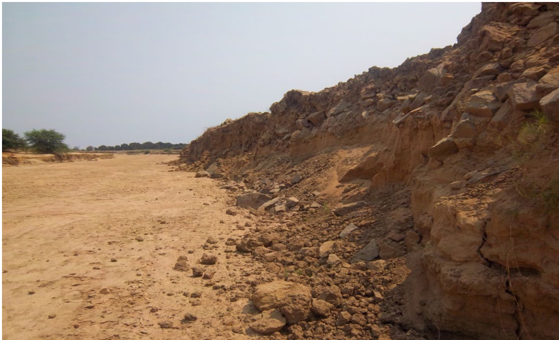
Figura 4.11- Estado actual de diques no rio Cavaco a 5 km da ponte a montante.
