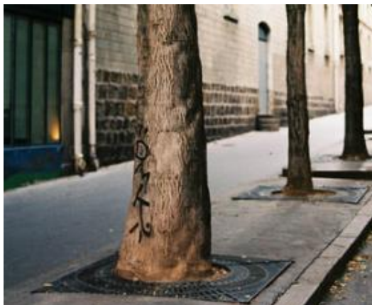
Figura 14 - Estrutura metálica de nivelção ao passeio colocada no sopé da árvore 33
