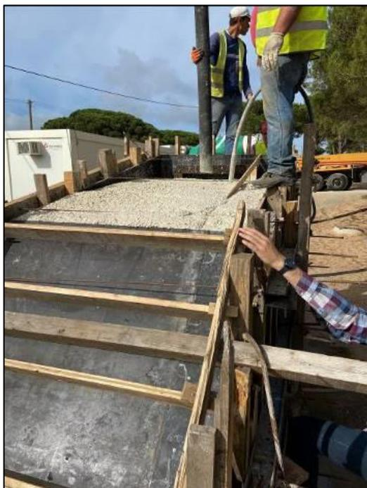
Figura 5.13 - Cofragem (2º painel) de cobertura inclinada.
