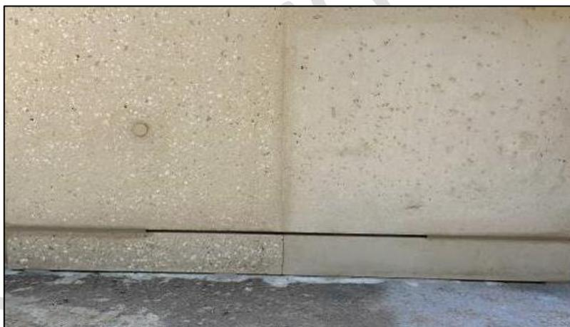
Figura 5.29 – Fixação dos rodapés.
