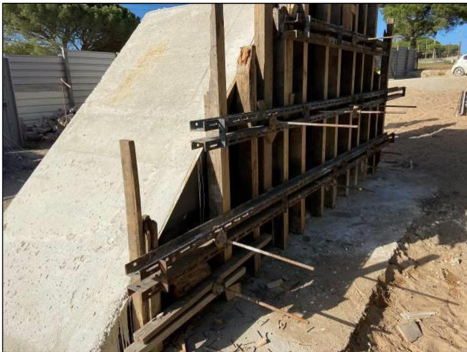
Figura 5.17 – Processo de descofragem.
