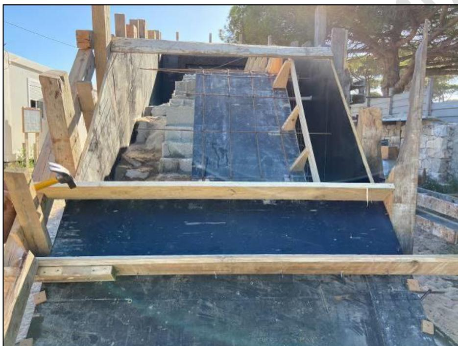
Figura 5.12 - Cofragem (1º painel) de cobertura inclinada.
