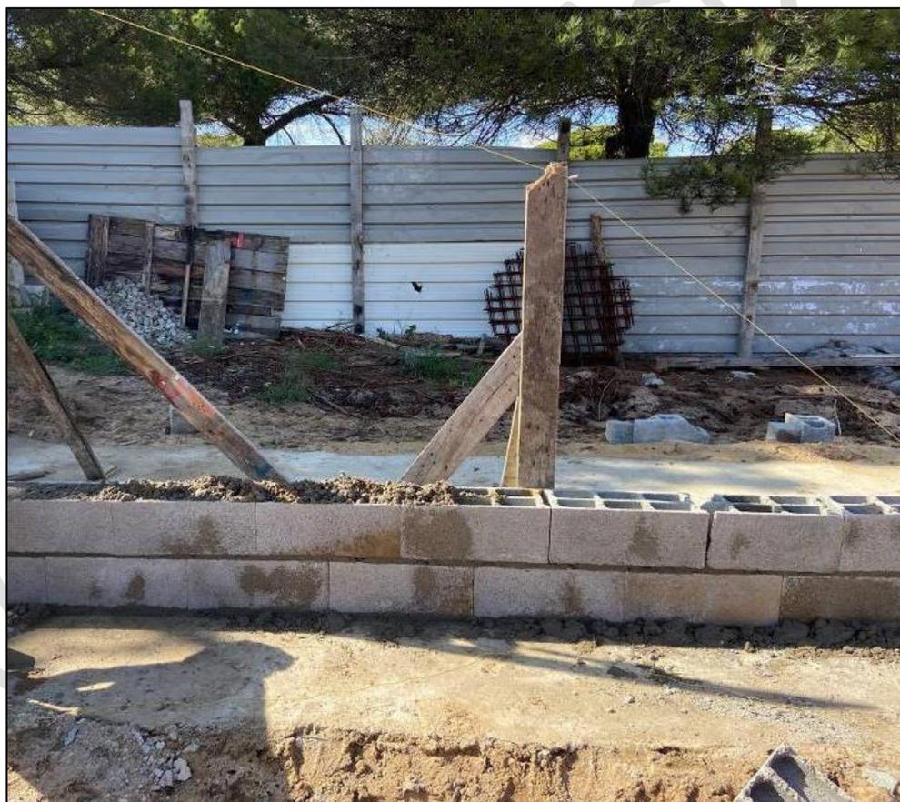
Figura 5.5 - Execução de parede em blocos de betão.
