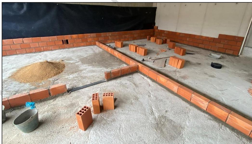
Figura 4.5 – Verificação de primeira fiada de alvenaria e imbricamento entre panos.
