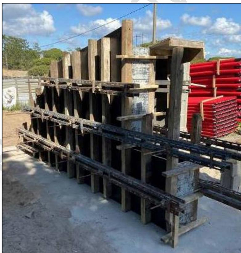
Figura 5.9 – Cofragem final para betonagem.
