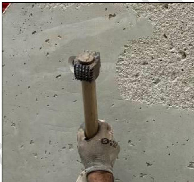
Figura 5.4 - Bujarda para execução de acabamento em bujardado manual.
