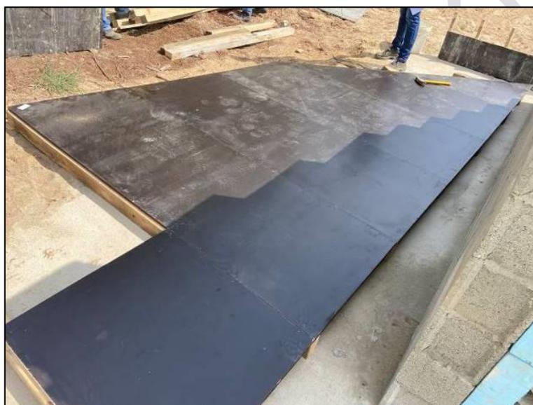
Figura 5.7 – Painéis de cofragem com zero utilizações.
