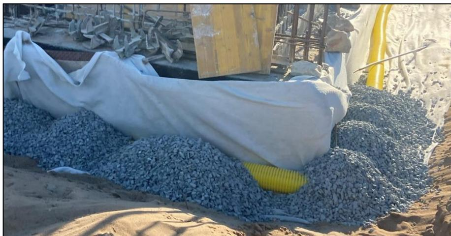
Figura 4.8 – Aplicação de geodreno e camada britada.
