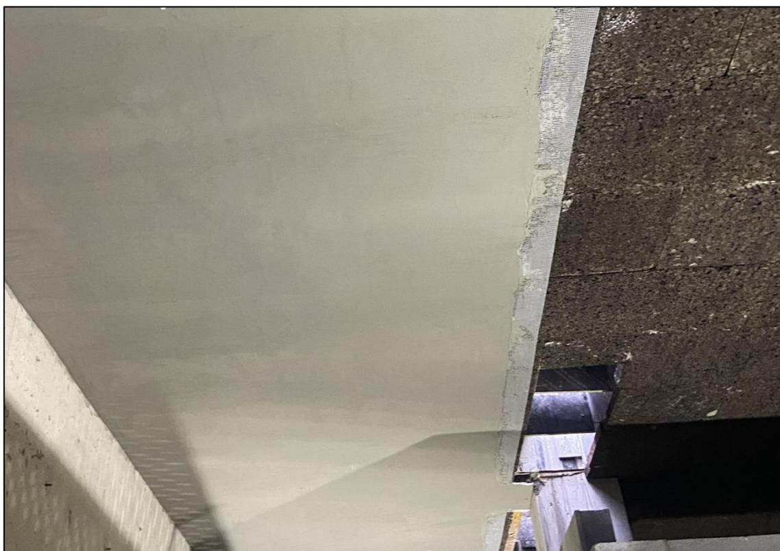
Figura 4.10 – Demonstração da aplicação do sistema: aglomerado negro de cortiça, rede fibra de vidro e impermeabilização à base de cimento.
