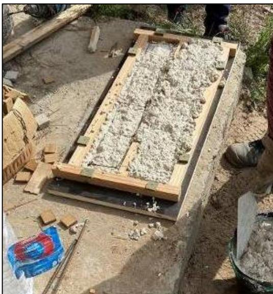
Figura 5.28 – Produção dos rodapés em betão pré-fabricado.
