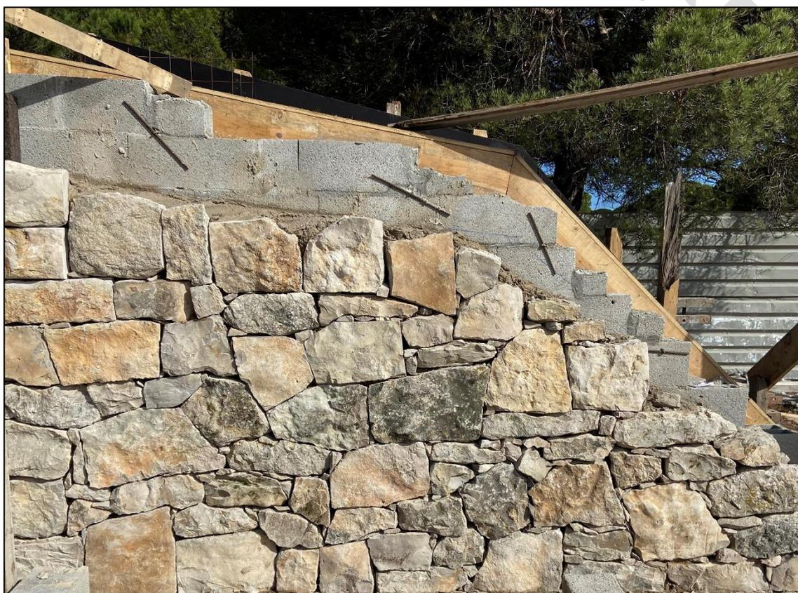
Figura 5.6 - Amostra final de parede em pedra rústica emparelhada.
