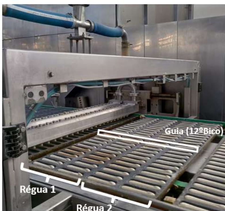
Figura 3.2. Processo de injeção de massa.
