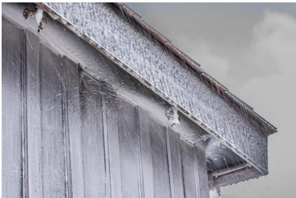
**Figura 2.4.** Espuma classe A como proteção contra incêndio [10].
