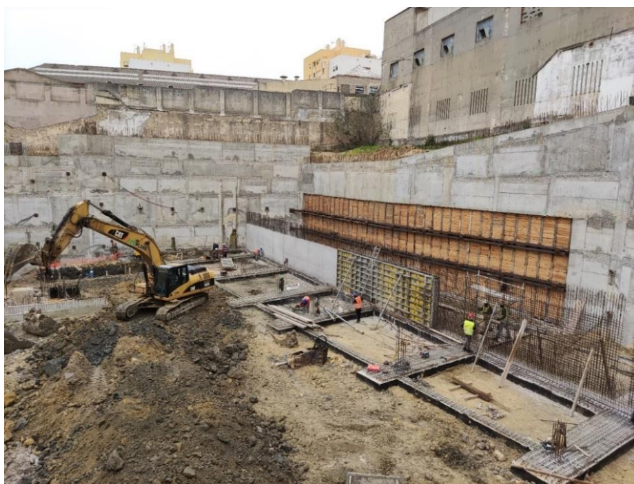
Figura 28 – Lote 1 - Paredes de contenção e muro periférico parcialmente executado (JET SJ , 2021).
