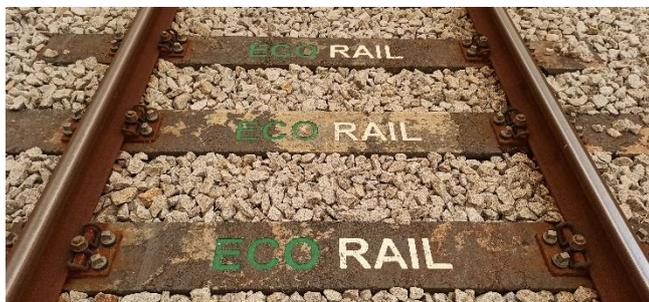
Figura 3.7 - Travessas de material compósito aplicadas na Linha do Leste
