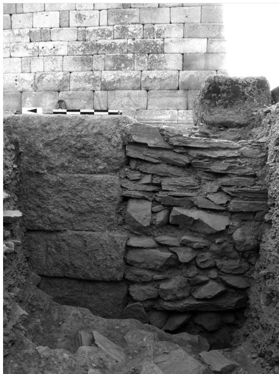
Figura 10. Troço de alicerce do pórtico que rodeava o templo a ocidente, observando-se a alternância entre dois aparelhos construtivos diferentes, em granito e xisto (Sondagem 1).
