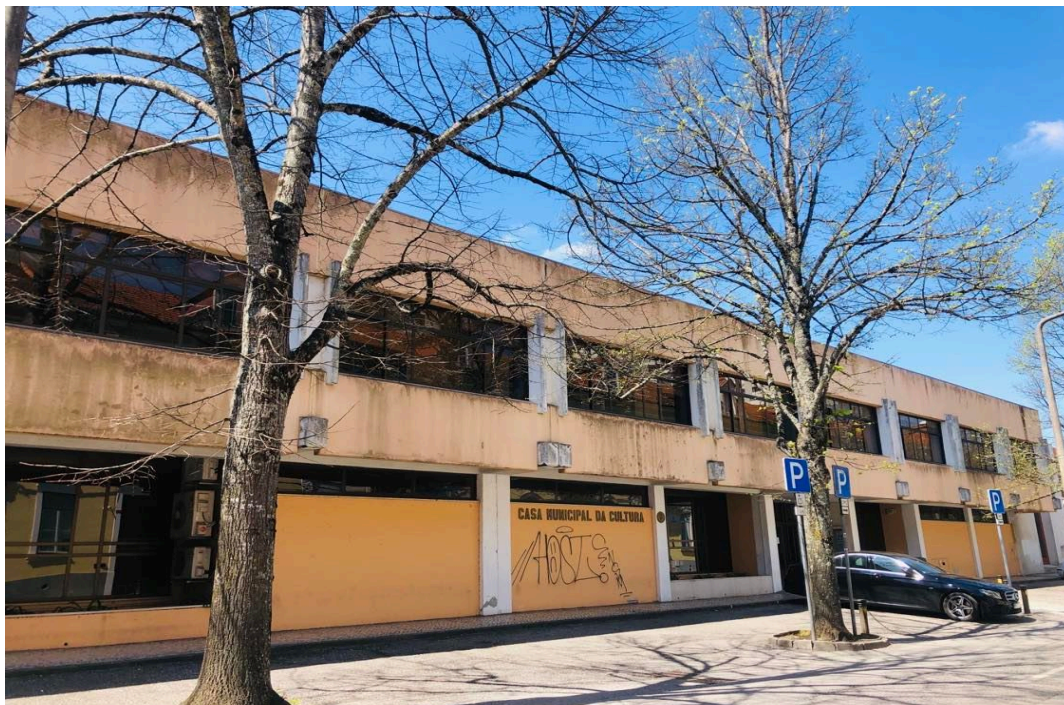
Figura 6: Casa Municipal da Cultura de Coimbra. (Foto da autora)
