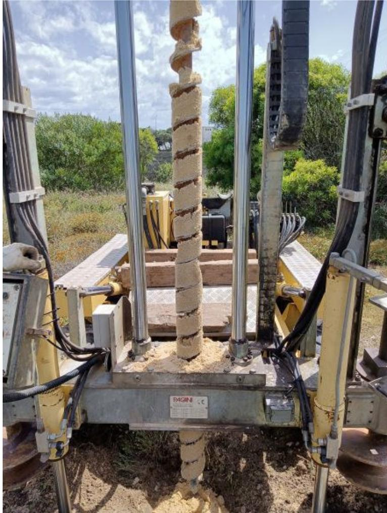
**Figura 3** – Exemplo de execução de um trado mecânico.
