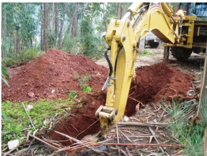
**Figura 2** – Exemplo de execução de um poço de prospeção com retroescavadora.
