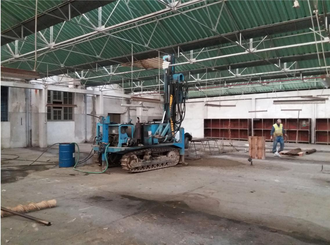
**Figura 14** – Execução da sondagem S5, com equipamento SMA-630.
