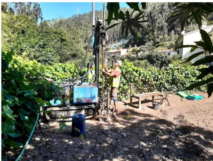
**Figura 7** – Exemplo de execução de uma sondagem com ensaios SPT.
