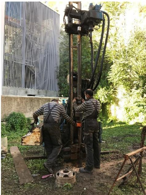
**Figura 10.** Equipamento utilizados na realização das sondagens.
