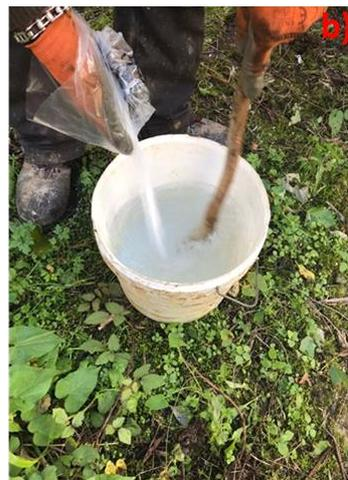
**Figura 13.** a) Polímero; b) Aditivo adicionado à água para facilitar a saída de material no decorrer da furação.
