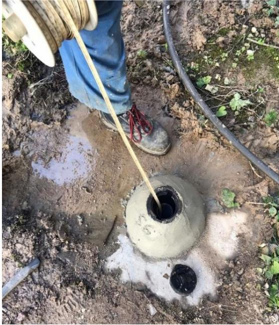
**Figura 12.** Piezómetro instalado na sondagem S6.
