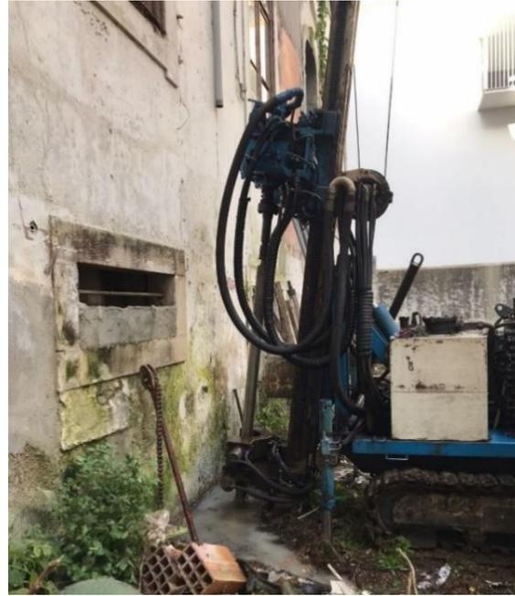
**Figura 11.** Sondagens S8 com cerca de 7° de inclinação.
