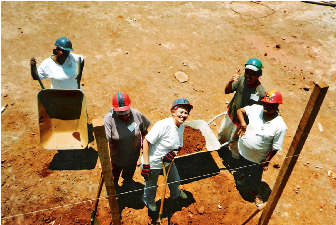
Fig. 38 | Momento pausa durante a construção do Conjunto Habitacional Paulo Freire
