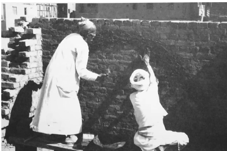
Fig. 24 | Pedreiros traçam uma parábola com lama para iniciar uma abóbada
