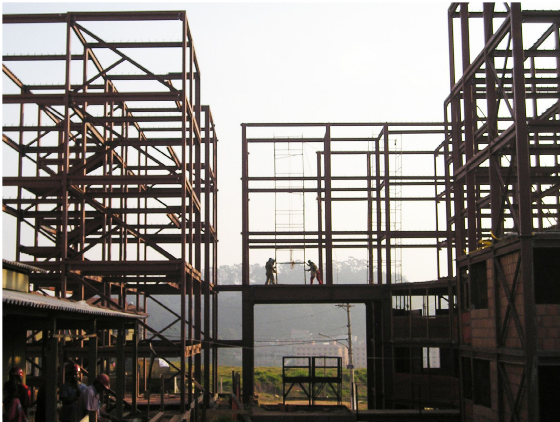
Fig. 37 | Construção da estrutura de aço do Conjunto Habitacional Paulo Freire
