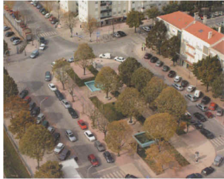
K. Reabilitação Avenida da Estação, G. de Apoio Técnico da Guarda
