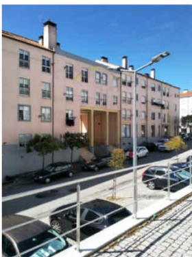
H. Conjunto Habitacional Quinta do Pinheiro, Prémio INH, Coord. Arquiteto Aires Almeida, Gabinete Técnico da Guarda.
