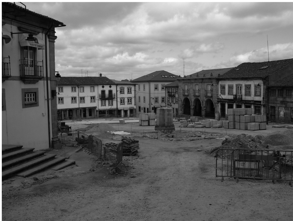
7.14. Trabalhos de construção na Praça Luís de Camões (Praça Velha). Fonte: Rui Jacinto, abril de 2005.
