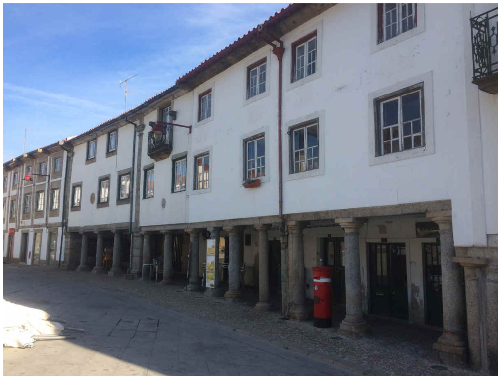
3.7. Bloco de Casas Porticado. Julho 2017.
