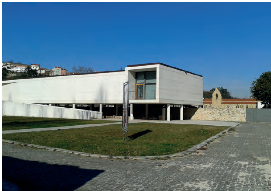
FIGURA 13 Centro de Interpretação do Mosteiro de Santa Clara-a-Velha, Coimbra (fotografia da autora, 2015).
