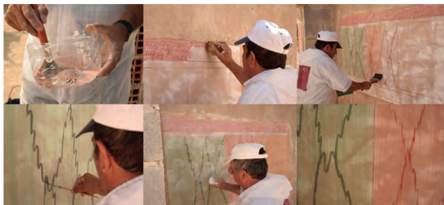
FIGURA 3 Execução de fingido [Câmara Municipal de Albufeira, Filipe Palma e Rui Gregório].
