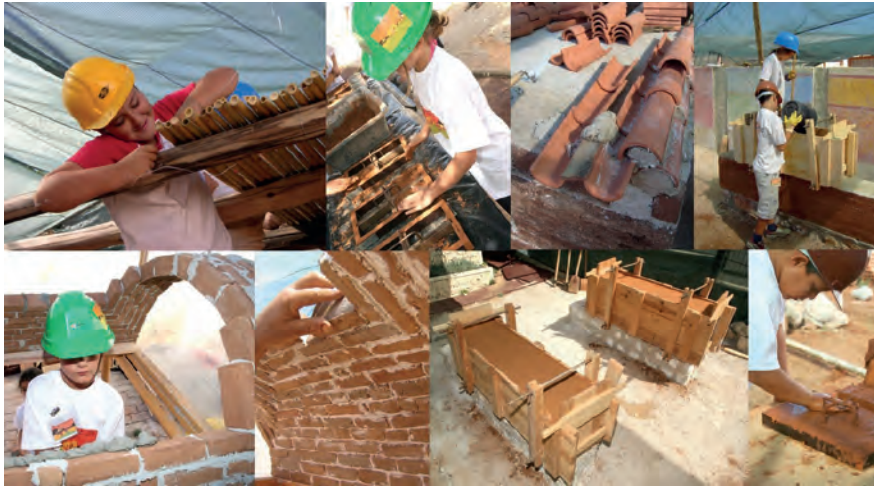
FIGURA 11 Construção de casa em taipa, forro de caniço e cobertura em telha e execução de abóbada de berço e adobes (Câmara Municipal de Albufeira, Filipe Palma e Rui Gregório).
