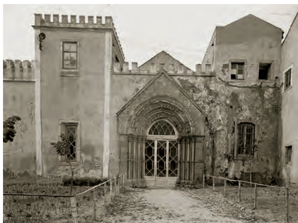
FIGURA 6 Convento de São Francisco em Santarém: antes intervenção da DGEMN (SIPA-DGPC, FOTO.00520540, 1948).
