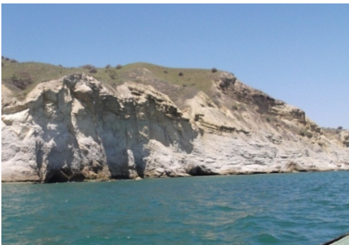
Fig. V.9 – Aspectos de tombamento (sector esquerdo da foto) e de deslizamento translacional (sector direito da foto).
