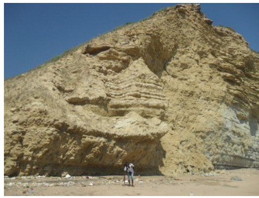
Fig. V.8 – Deslizamento translacional em cunha a sul da praia da Hanha.
