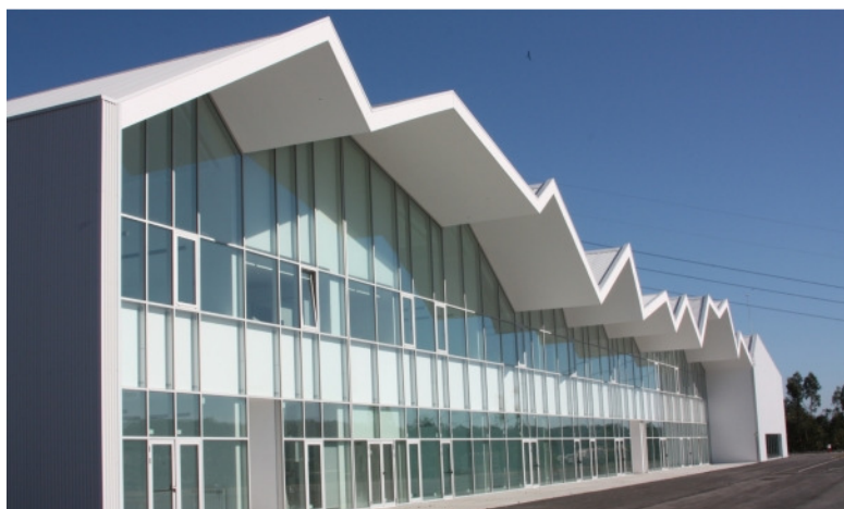
Figura 3.1. – Fachada principal da Escola Básica e Jardim-de-infância EB1/J1 de Vilela.
